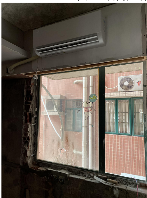
(图 3 客房空调安装情况)
