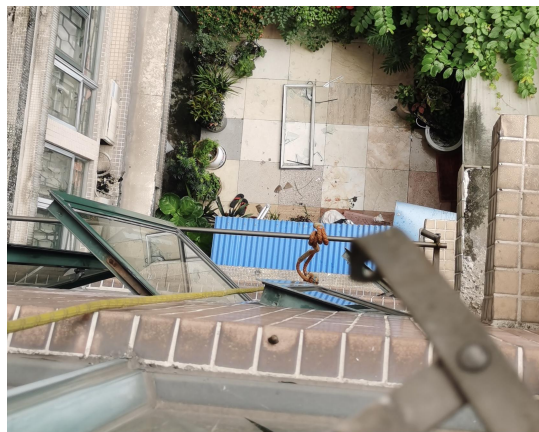
(图9 安全绳垂下至5楼、窗扇掉落)
