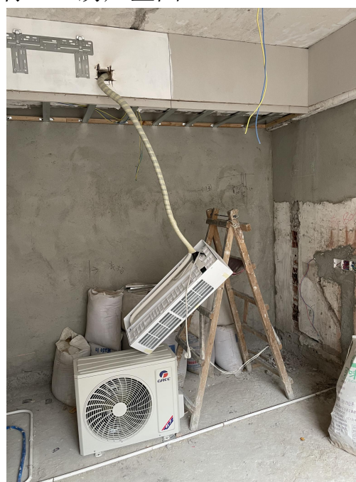
(图 4 次卧空调安装情况)
