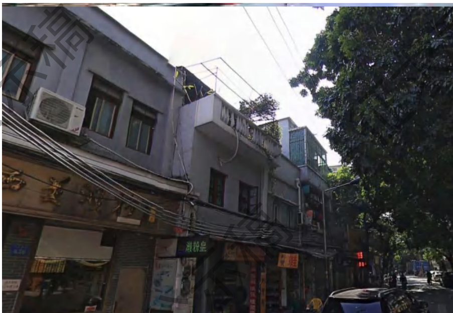
2013年，荔湾区光复中整饰后外立面风貌
