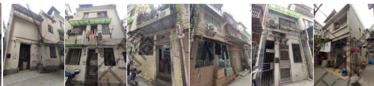
三围街沿线建筑
