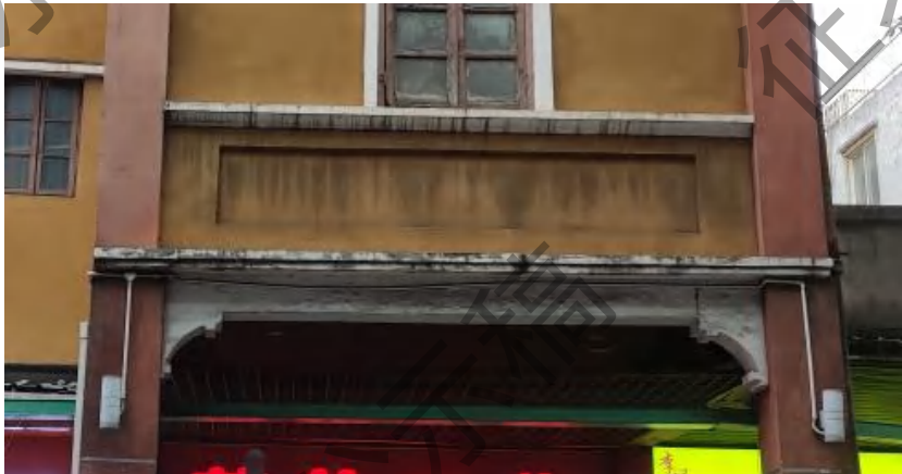
特色造型过梁、栏板装饰、腰线装饰
