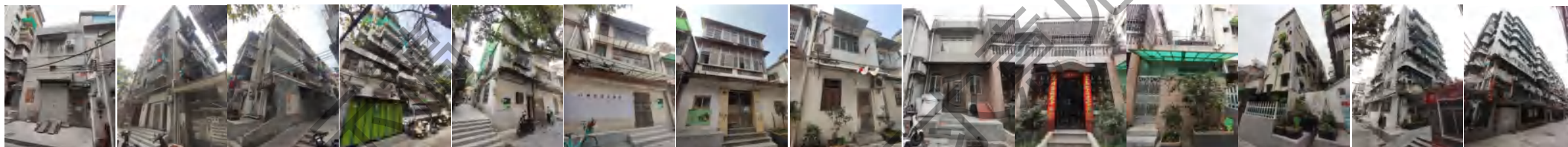
六甫水脚西侧沿线建筑
