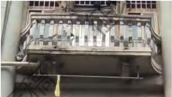
特色阳台、混凝土栏杆、梁托
