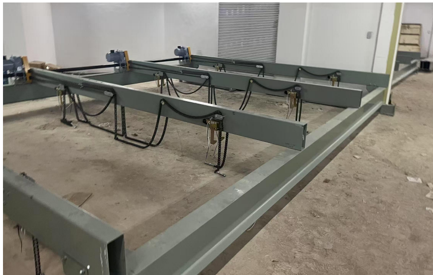
图 3 原地已完成组装的停车设备上框架
