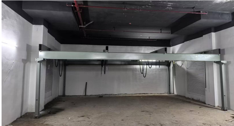
图4 已完成立柱安装的停车设备
