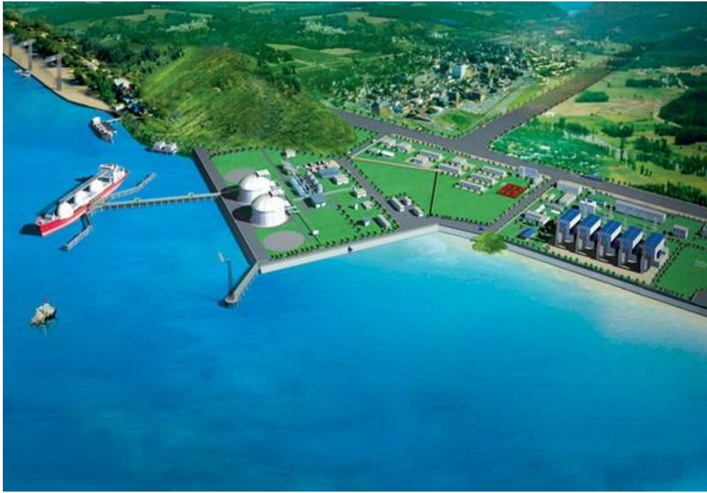
图 5.2-5 珠海金湾 LNG 接收站
