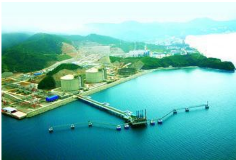
图 5.2-1 深圳大鹏湾 LNG 接收站实景图
