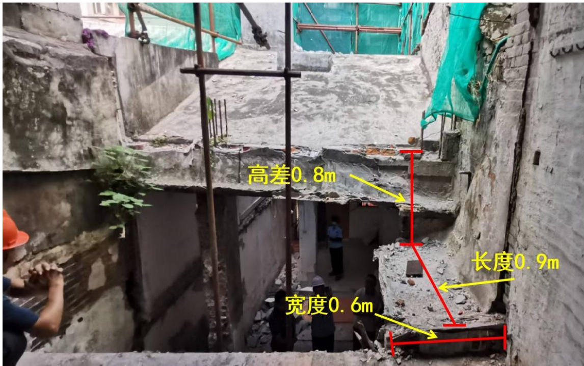
图6 采光井通道板尺寸
