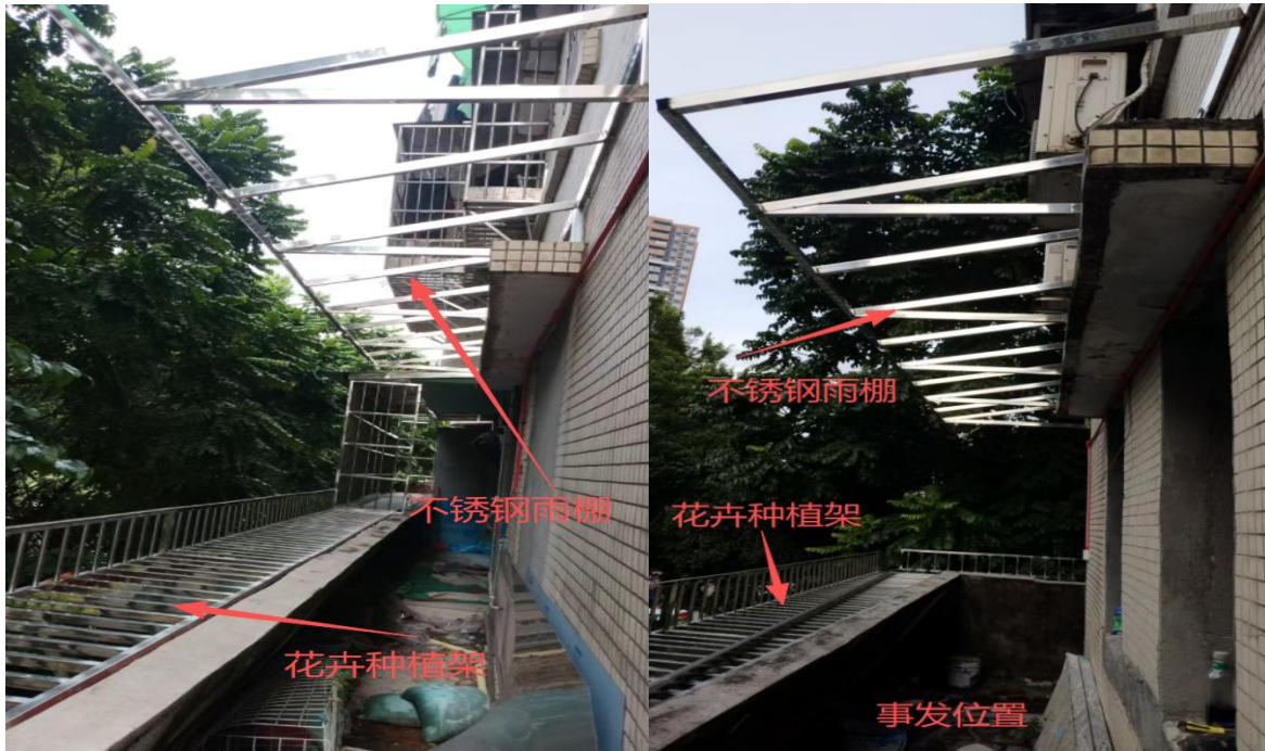
图 4、5 东北侧（左图）及西北侧（右图）阳台不锈钢雨棚和花架
