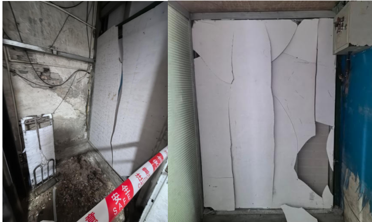
图 26、图 27 通道井壁南侧墙体内侧及外侧图
