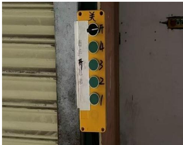
图 19 通道井门口旁的控制器图
