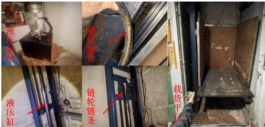
图 13、图 14、图 15、图 16、图 17 液压升降设备各部件图
