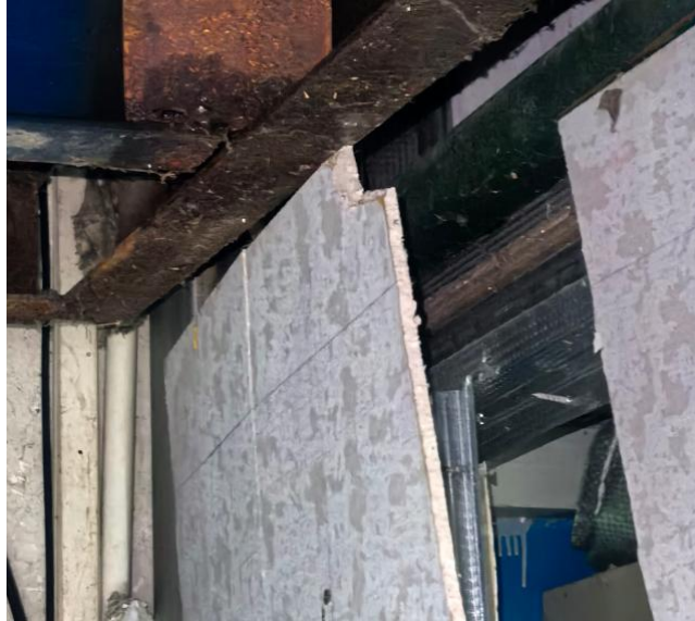
图 36 隔墙板竖向支撑住载货平台的自重
