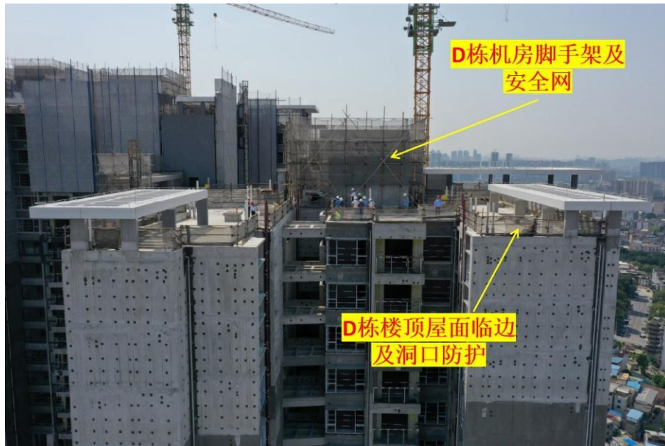
图 12 D 栋楼顶航拍图
