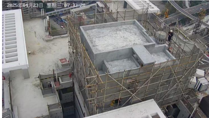
图7 7时32分，陈某再次站在D栋机房顶卸料 (图显时间约快1分钟30秒)
