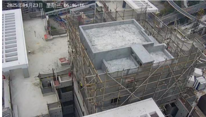
图5 6时45分，砼工班组抵达D栋机房 (图显时间约快1分钟30秒)
