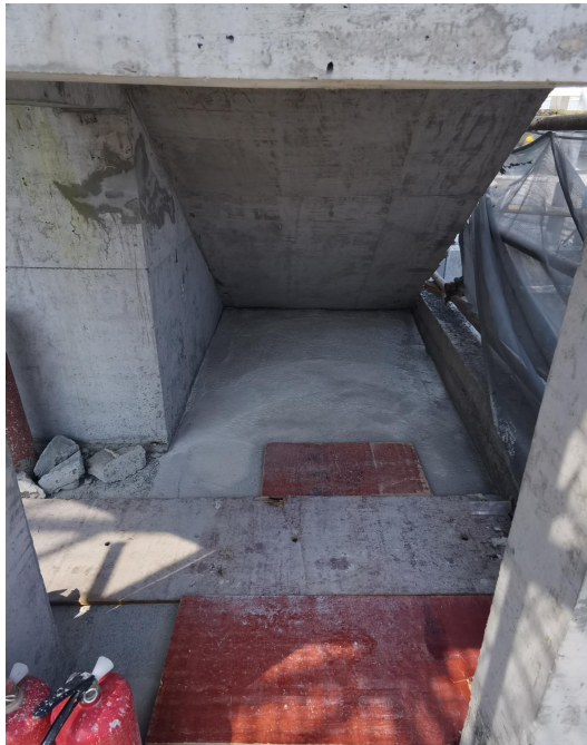
图 19 事发时尹某芬正在该楼梯下方（即第二工作面）作业
