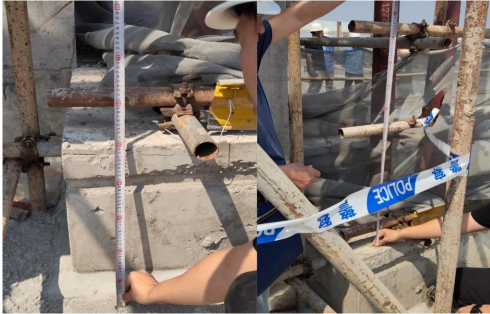
图 16 事发部位屋面层防护栏杆
