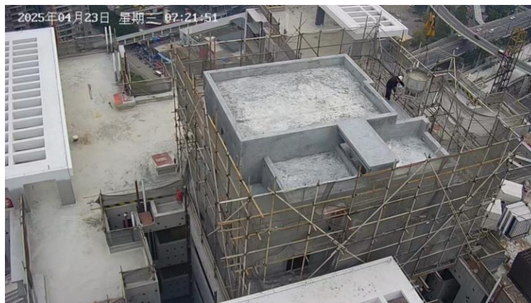
图6 7时20分，陈某站在D栋机房顶卸料 (图显时间约快1分钟30秒)
